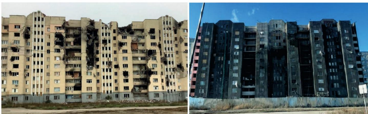
Рисунок 2– Поврежденный и восстановленный вид здания [102]
