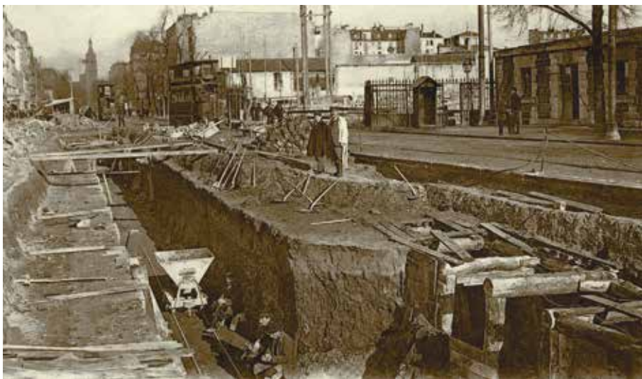
Открытие. Париж. Строительство железной дороги Метрополитена. 1904–1910-е гг. Государственный музей истории Санкт-Петербурга
